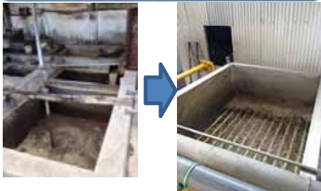
既存の排水処理槽
