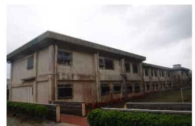
老朽化した刑事施設の外観の様子
