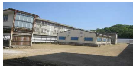
老朽化した刑事施設の外観の様子
