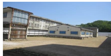
老朽化した刑事施設の外観の様子
