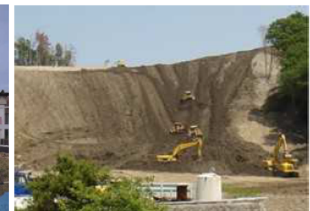
危険箇所対策 (土砂の撤去)
