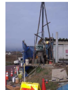
詳細調査 (ボーリング)
