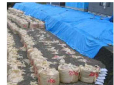
応急対策 (土留工)
