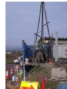
詳細調査 (ボーリング)
