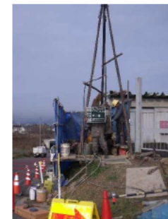
詳細調査 (ボーリング)
