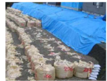
応急対策 (土留工)
