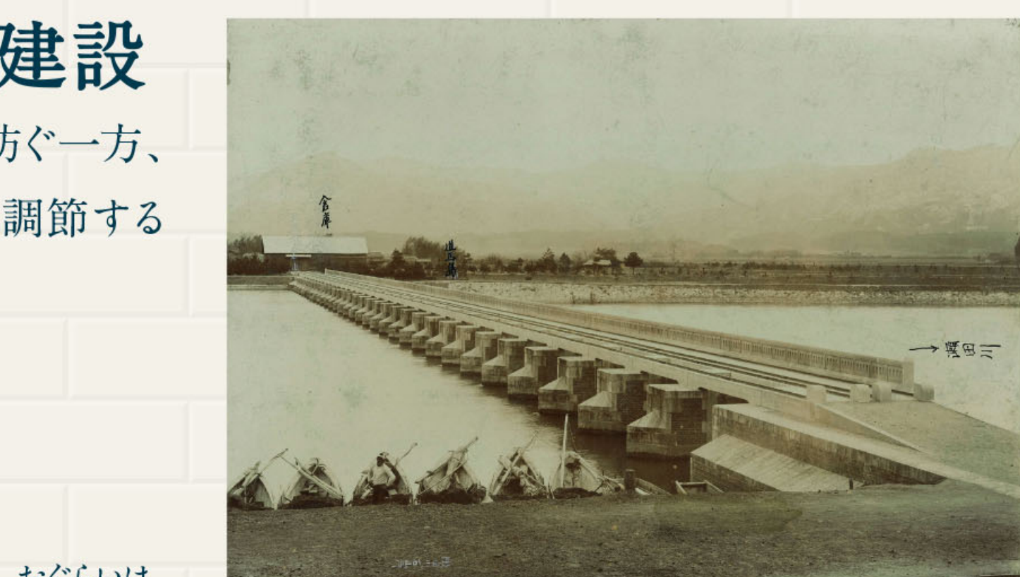
完成した瀬田洗堰。提供:国土交通省 淀川資料館
