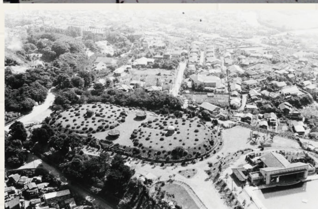
取水口(上)と野毛山配水池(下) 相模川と道志川の合流点に取水口を建設し、導水して野毛山で浄化されました。水源でコレラ菌が入る心配がないことや、水を送る際の汚染リスクが低下したこと、コレラの災禍に悩んでいた関係者は安堵したといえます。
