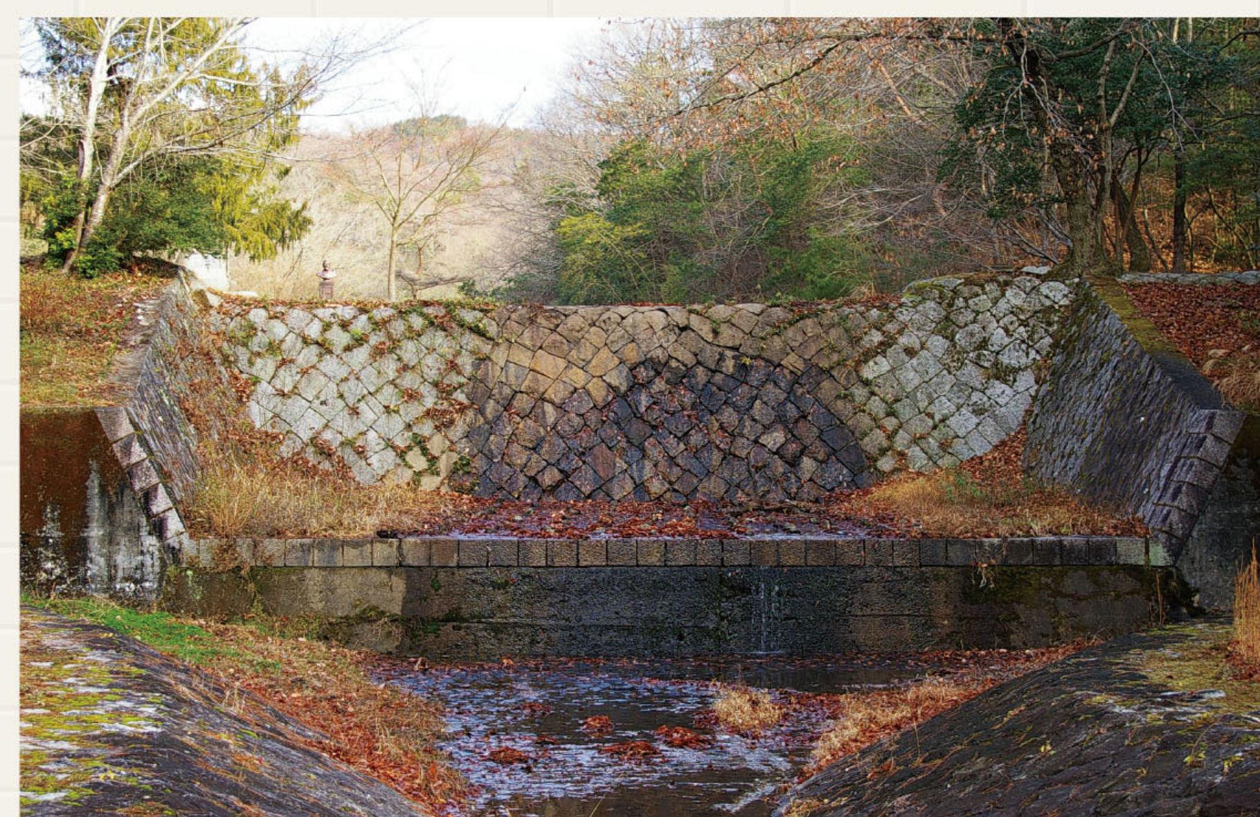
デ・レーケが指導した土砂をせきとめる堰の一つ。(不動川砂防施設) 提供：独立行政法人水資源機構(※の土木遺産 不動川砂防施設「水と土」(2011年)掲載)
