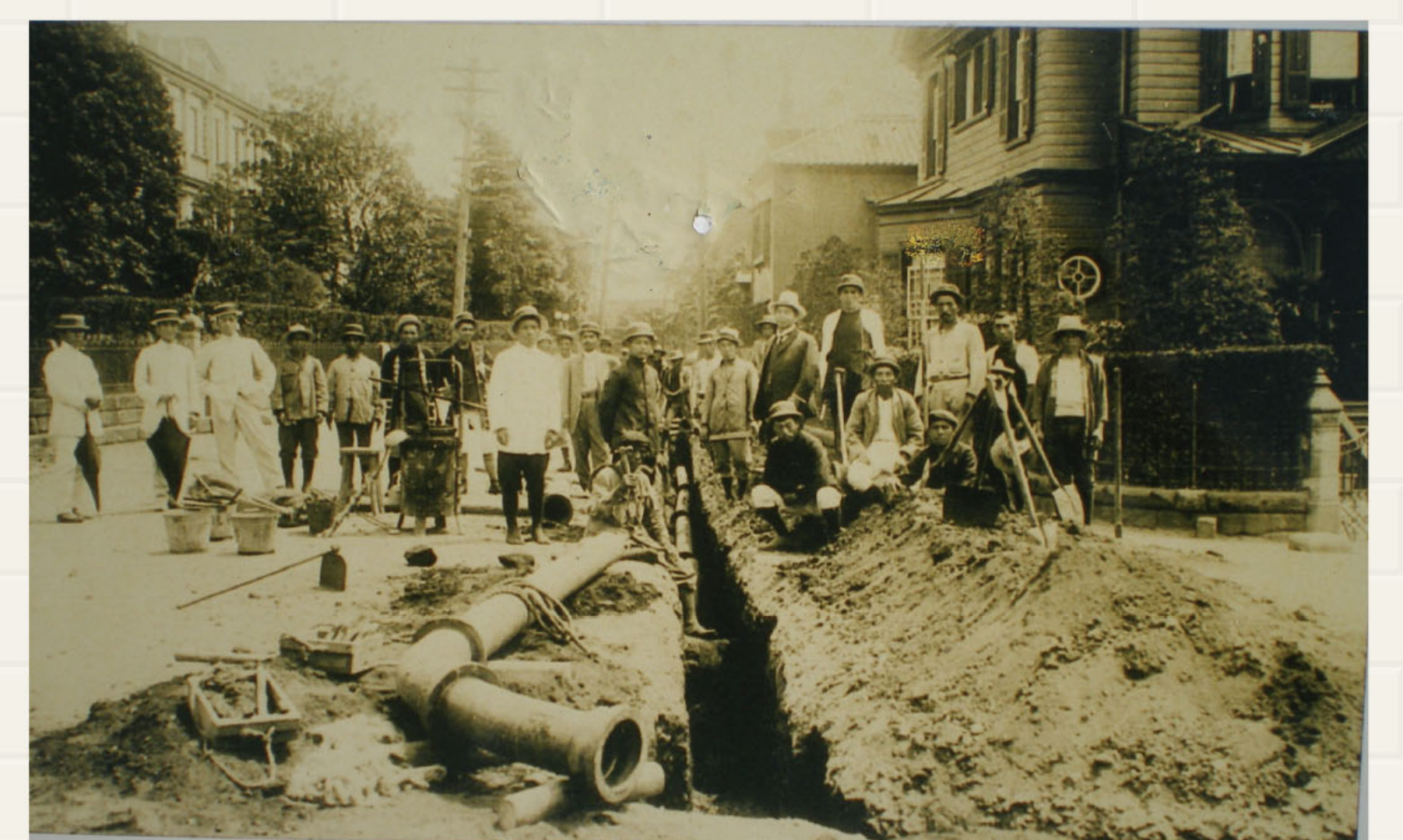
高まり続ける需要 ～拡張工事～
