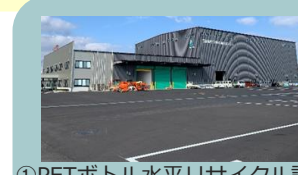
①PETボトル水平リサイクル設備
