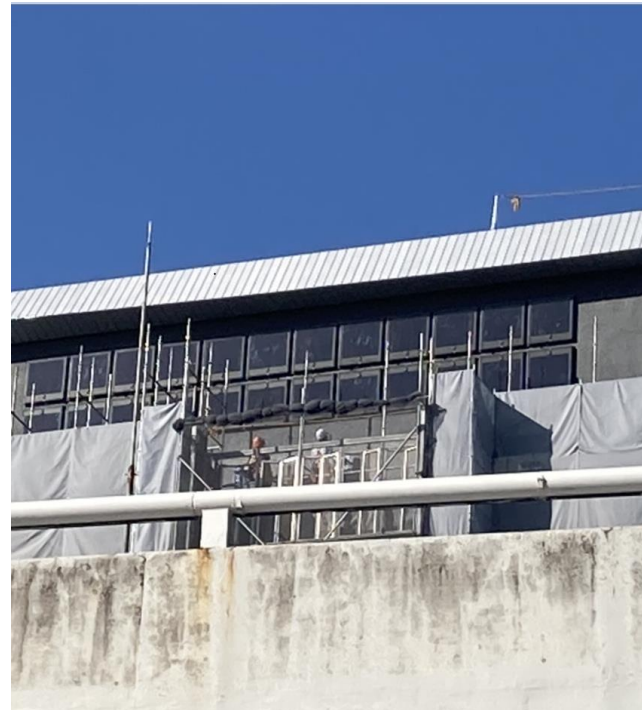
建物壁面への実装工事の様子
