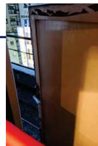
ベランダに抜ける扉を利用した換気
