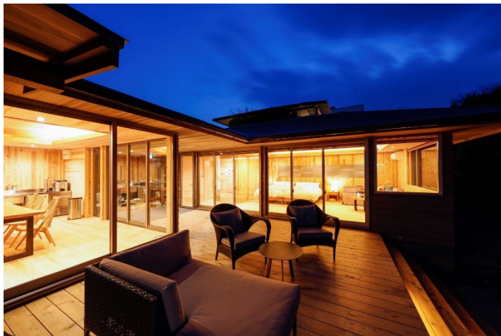
壁・天井CLTあrawし
