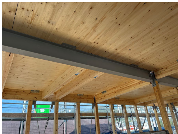
1階天井（2階床）CLT（工事中）
