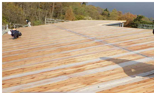
屋根CLT（工事中）
