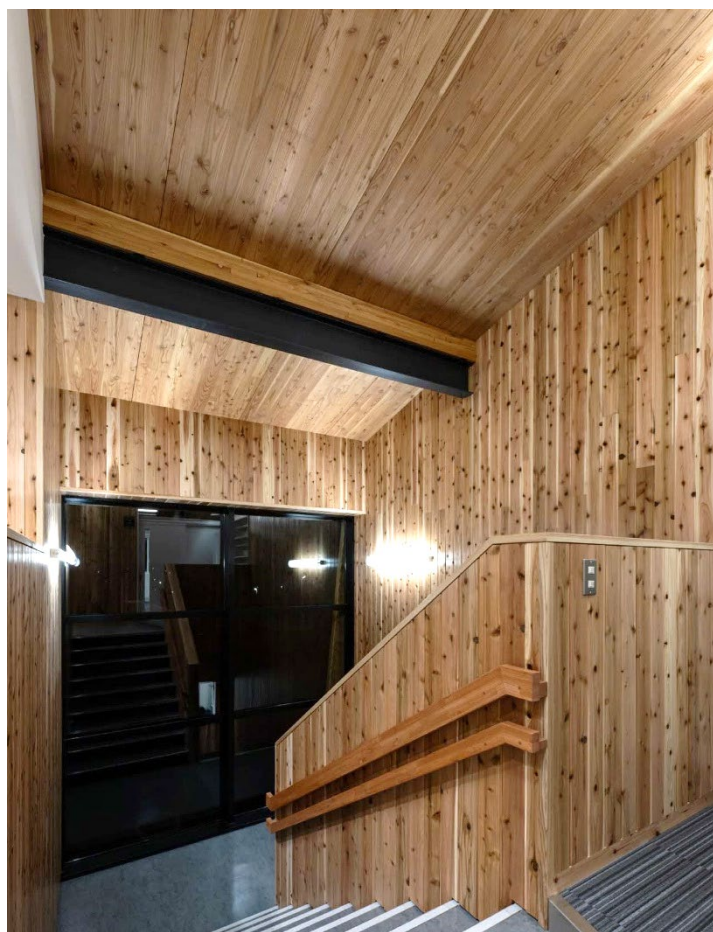
天井（屋根）CLT
