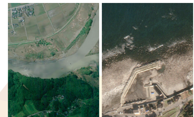
熊本県(令和2年7月熊本県豪雨による橋梁消失) 石川県(令和6年能登半島地震による隆起)
