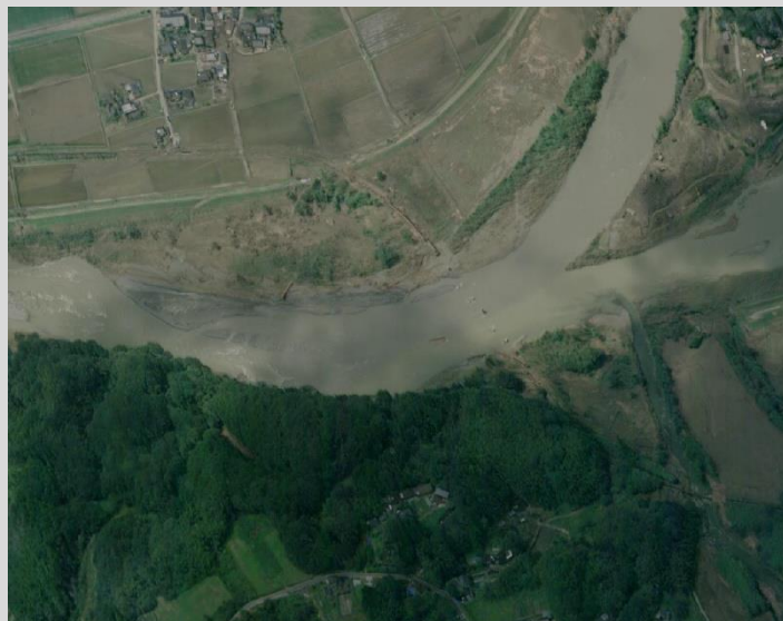
熊本県人吉市中央部 (令和2年7月豪雨による橋梁消失)
